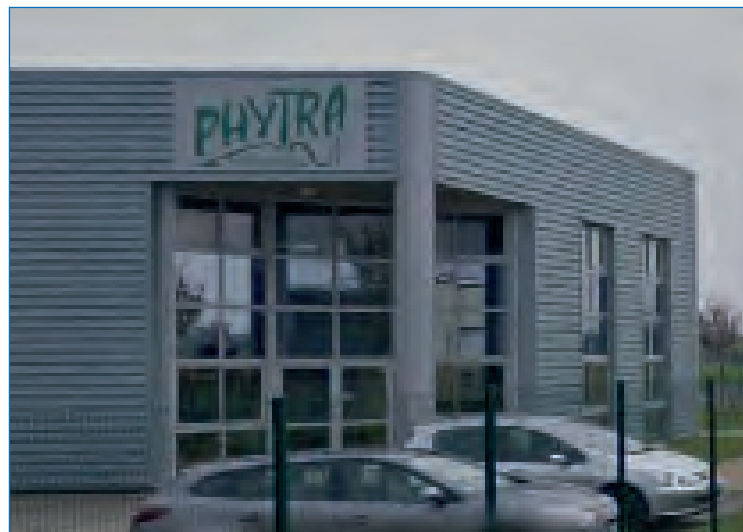
■ Enseigne sur façade légale
