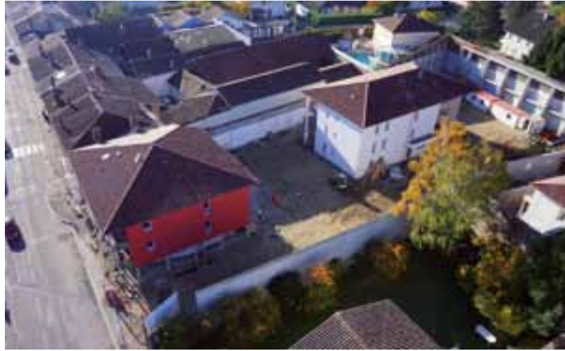
La microcrèche (au rez-de-chaussée du bâtiment blanc) est située à La Neuve, avenue de Mâcon qui a besoin d'être requalifiée.
