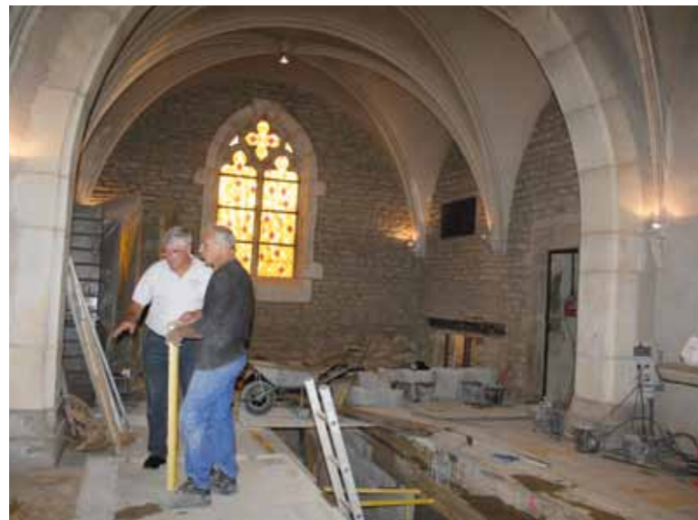
Trois mois de travaux sont nécessaires pour améliorer le chauffage dans l'église.
