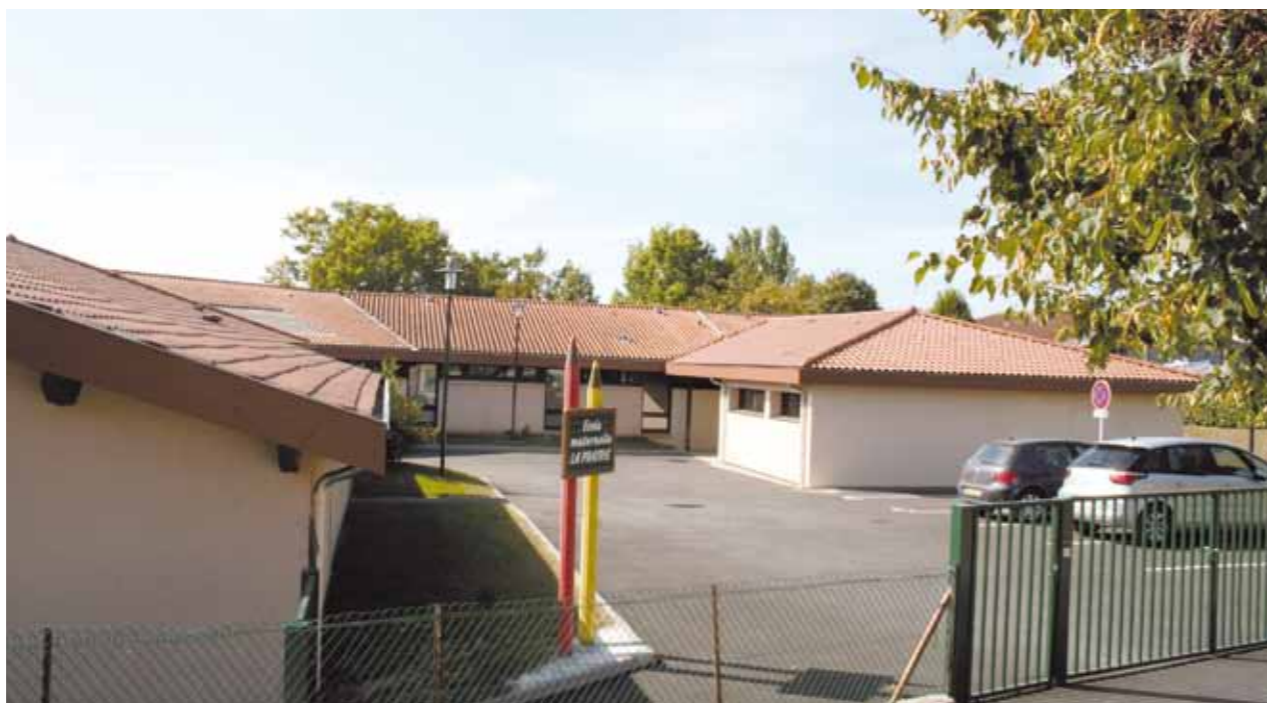
Une nouvelle aile a été construite et les places de stationnement ont été matérialisées.
