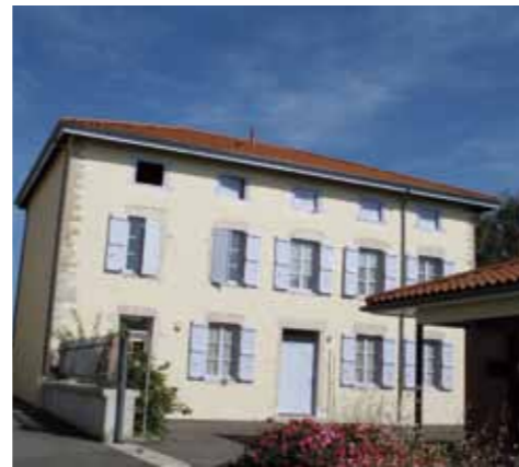
Les façades de la cure ont été rafraîchies.
